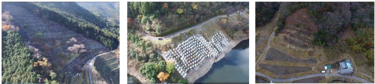
大迫ダム左岸ブロック
