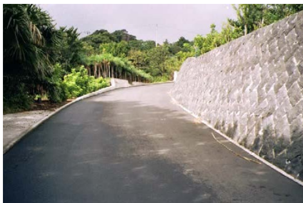
写真-24.2 地元産の石材を利用した擁壁
