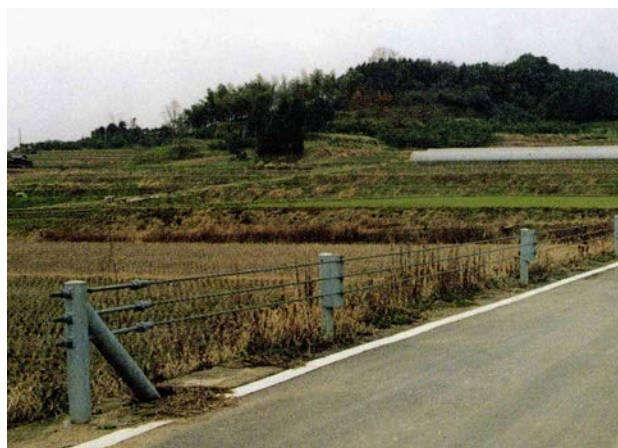
写真-24.3 ガードケーブル設置状況 (内部景観への影響)
