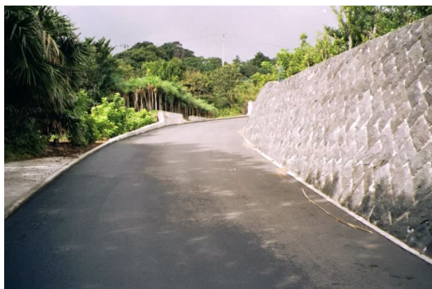
写真-24.2 地元産の石材を利用した擁壁
