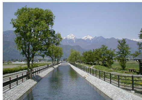
写真-3.3 改修工事後
