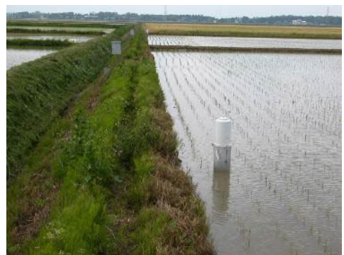
写真-6.5 自記水位計設置例
