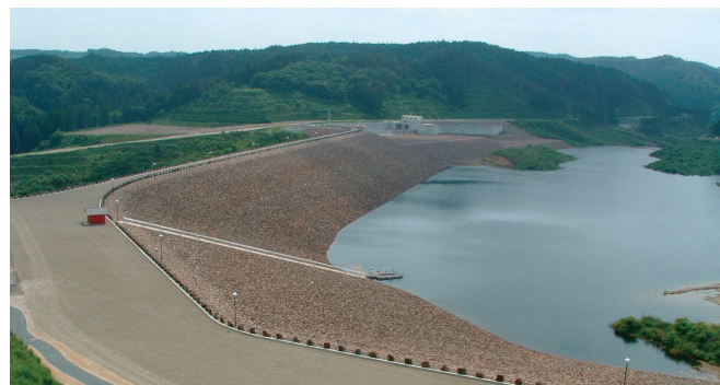
写真-15.2 整備後11年経過
