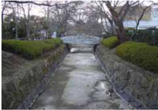
写真-16.2 導入前の状況
