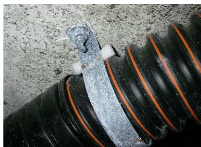
写真-14.13 シーリング材による対応
