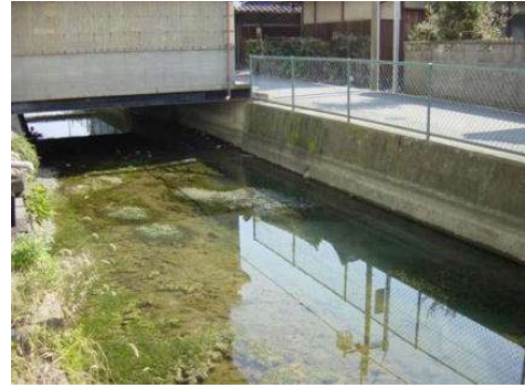
写真-9.2 水路の状況
