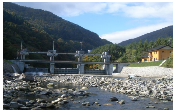
写真-15.5 事業実施後（近景）
