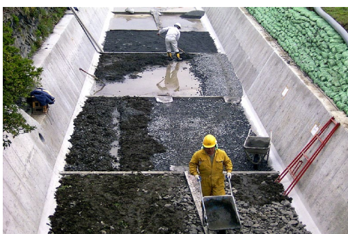
写真-14.4 施工状況
