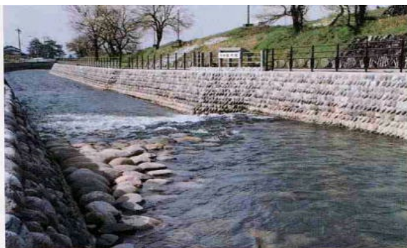
写真-15.8 事業実施後 - 水利遺構（堤）の保全
