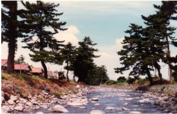
写真-15.6 事業実施前の用水路
