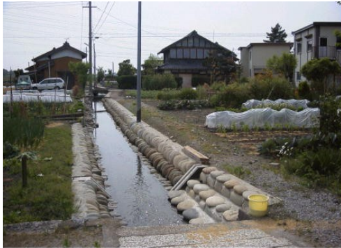
写真-1.3 親水水路に設置された洗い場
