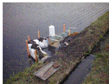
写真-6.2 水口側設置例
