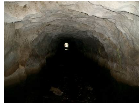
写真-14.7 改修前のトンネル
