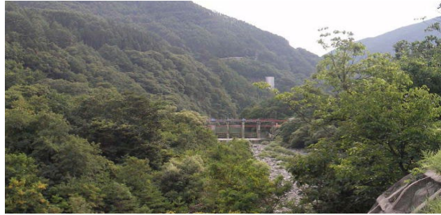
写真-15.3 事業実施前の頭首工（遠景）
