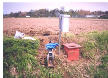
写真-6.3 落水口側設置例
