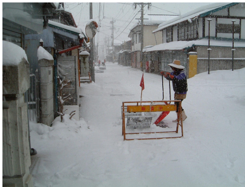
写真-1.7 用水路を利用した消流雪溝
