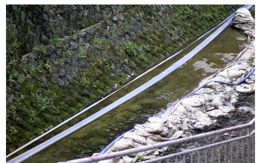
写真-14.3 仮移植先の状況
