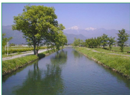
写真-3.2 改修工事前
