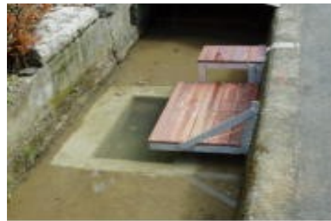
写真-1.6 洗い場下の防火桧
