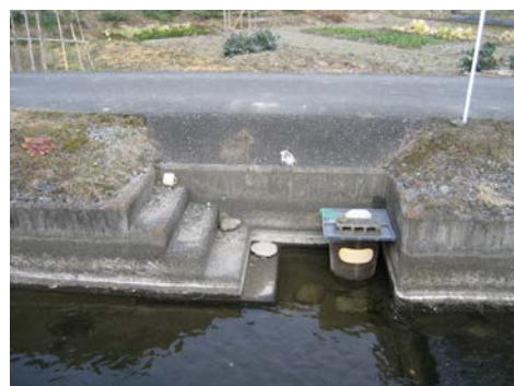
写真-1.2 用水路に設置された洗い場
