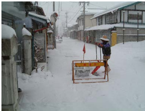
写真-1.7 用水路を利用した消流雪溝
