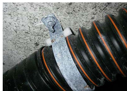
写真-14.13 シーリング材による対応
