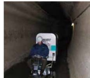
写真-13.2 計測状況
