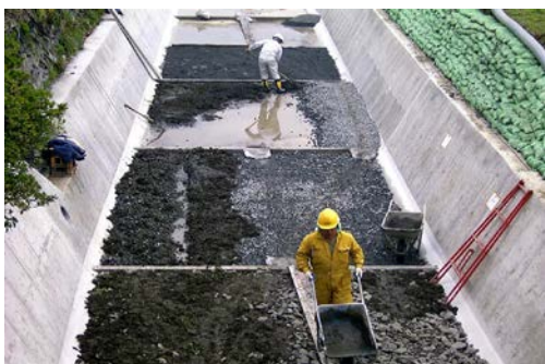
写真-14.4 施工状況
