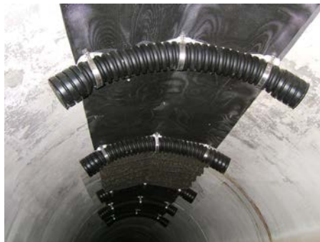
写真-14.9 設置後のコウモリピット
