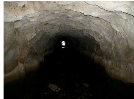
写真-14.7 改修前のトンネル
