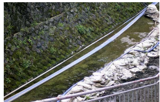
写真-14.3 仮移植先の状況
