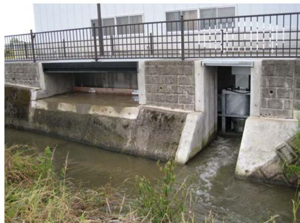
写真-22.2 導水路の余水吐 (左) と放水口発電機 (右)
