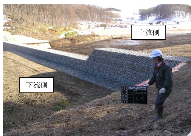
写真-18.2 沈砂池設置状況
