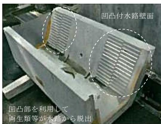
写真-16.1 環境配慮型側溝の事例
