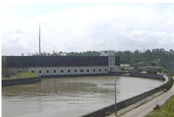
写真-15.6 事業実施前の排水機場
