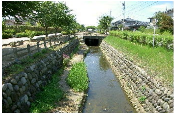
写真-15.5 事業実施後の排水路
