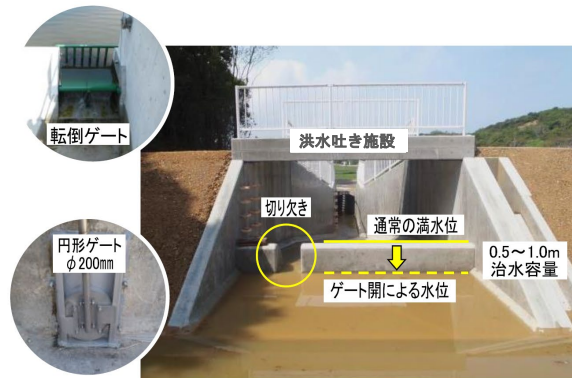
図-16.11 洪水吐き放流ゲート等の設置
