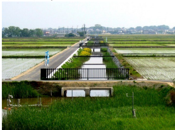
写真-15.17 多自然型排水路設置状況
