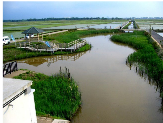
写真-15.18 多自然型浄化池設置状況
