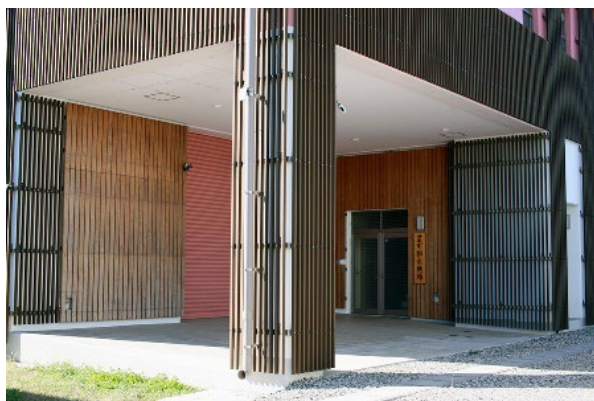
写真-15.9 整備後の排水機場入口部
