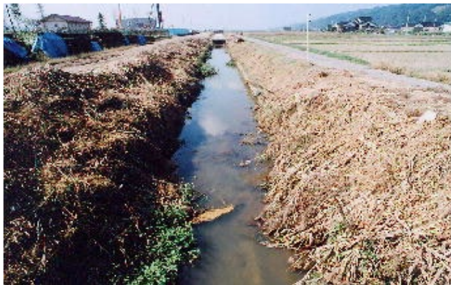
写真-15.4 事業実施前の排水路
