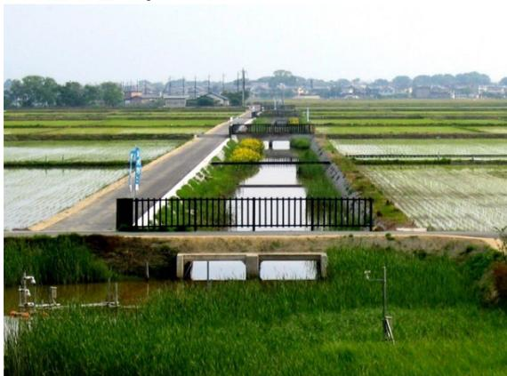
写真-15.17 多自然型排水路設置状況
