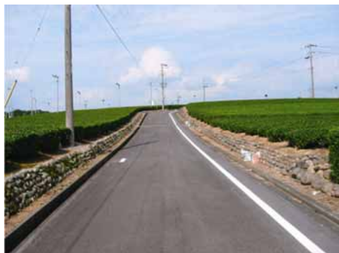
写真-6.6 茶園の石積み法面
