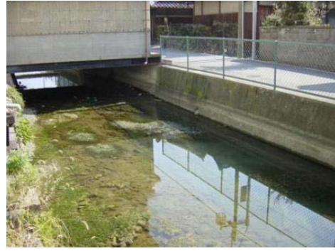
写真-9.2 水路の状況
