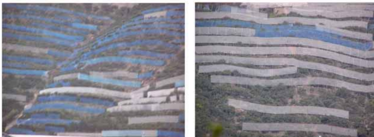
図-24.1 階段園の防風ネット設置状況
