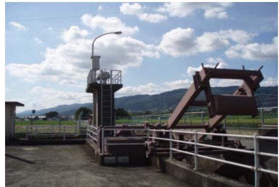
写真-20.1 水位調整ゲート(1)
