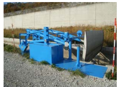
写真-20.2 水位調整ゲート(2)
