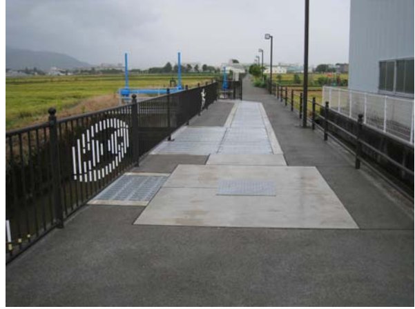
写真-22.4 取水路部の上部（下流側から撮影） （コンクリートの下に発電機が設置）
