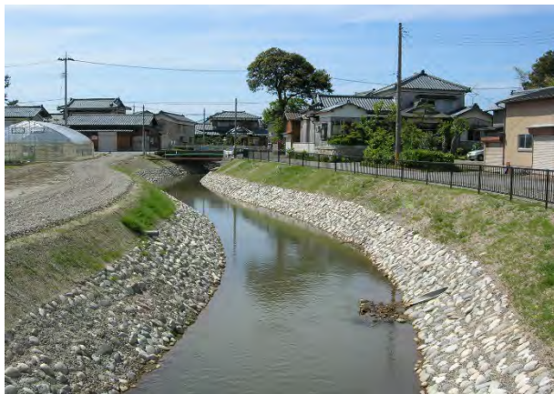
写真-15.15 緩勾配型自然石付金網護岸工設置状況
