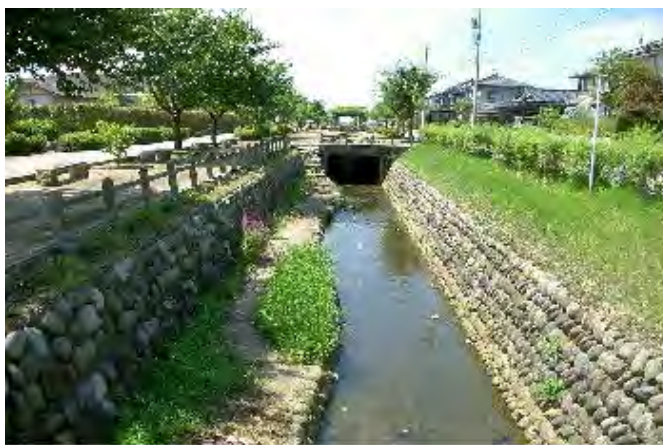
写真-15.5 事業実施後の排水路
