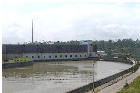
写真-15.6 事業実施前の排水機場
