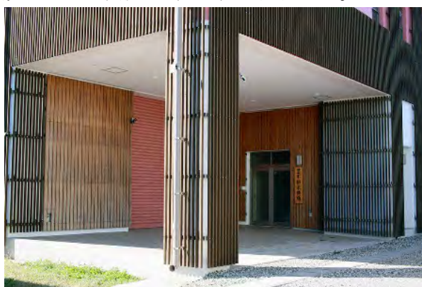
写真-15.9 整備後の排水機場入口部
