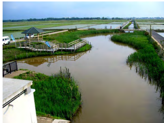
写真-15.18 多自然型浄化池設置状況
