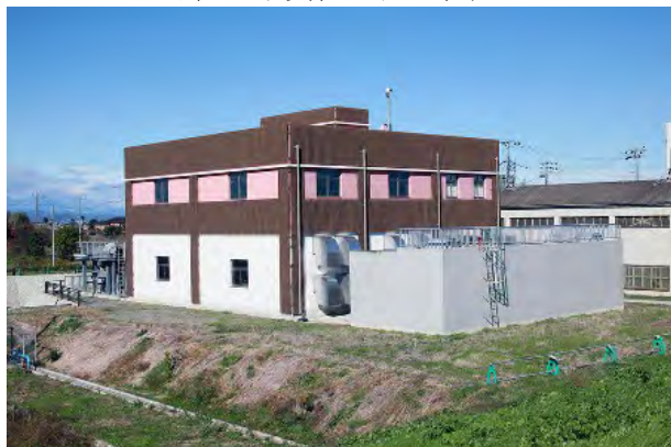
写真-15.8 整備後の排水機場全景
