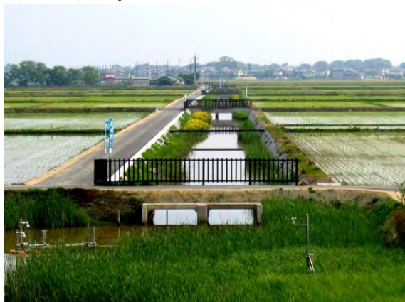
写真-15.17 多自然型排水路設置状況
