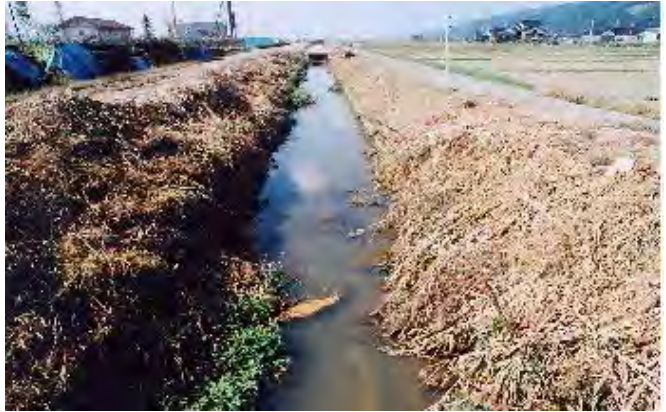
写真-15.4 事業実施前の排水路
