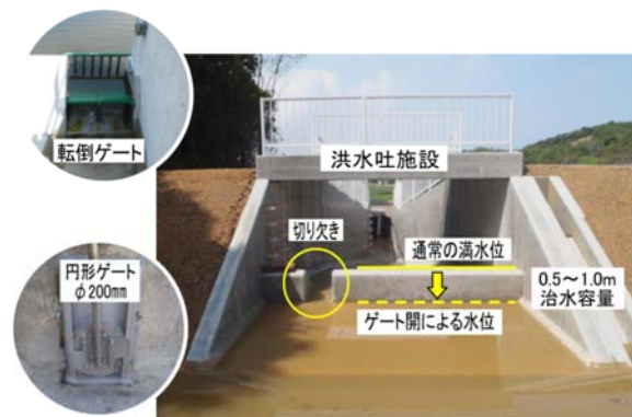
図-16.9 洪水吐放流ゲート等の設置
