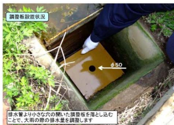
写真-16.1 調整板設置状況
