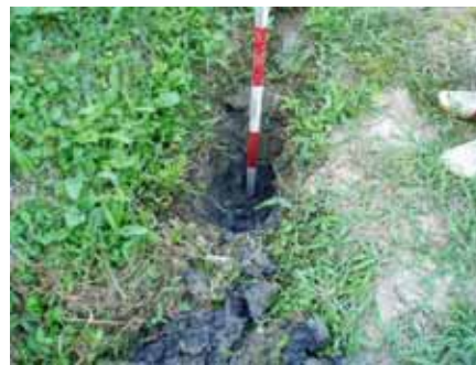
籾殻を敷いて暗渠とする
