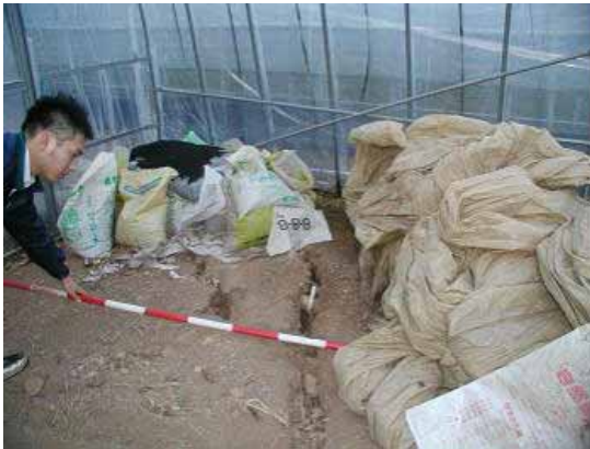
図 3-7 農地に発生した亀裂
