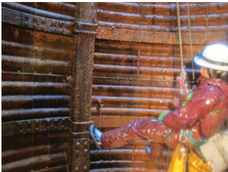
図-3 懸垂下降による詳細調査事例
