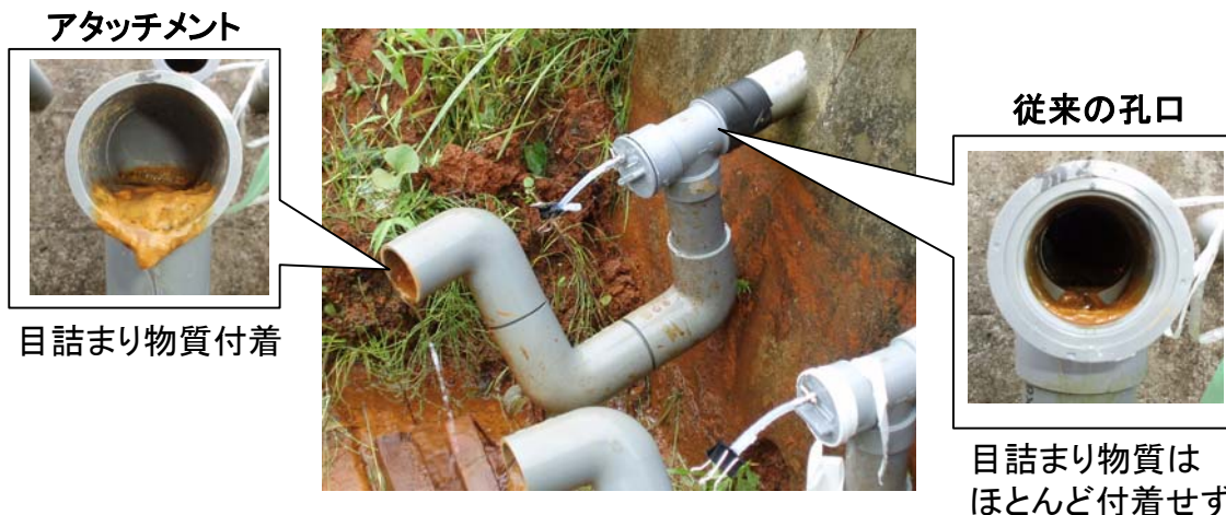
図11 目詰まり対策アタッチメント実証試験
