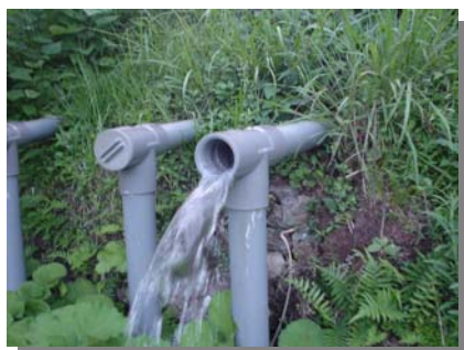
図1 地下水を排除する水抜きボーリング
