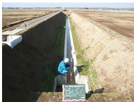
【排水路（事業実施後）平成21年10月撮影】
