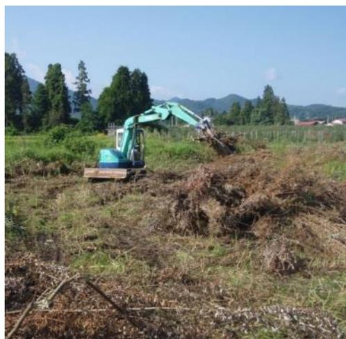
写真2 農地の再生（抜根作業）
