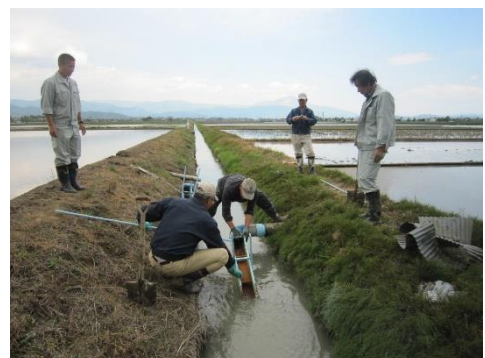
写真８ 魚道の設置
