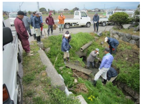
写真 4 排水路の補修(農地水環境守ろう会)
