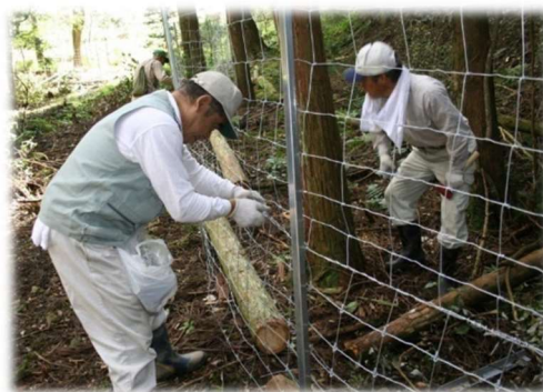
写真 2 獣害防除柵の設置
