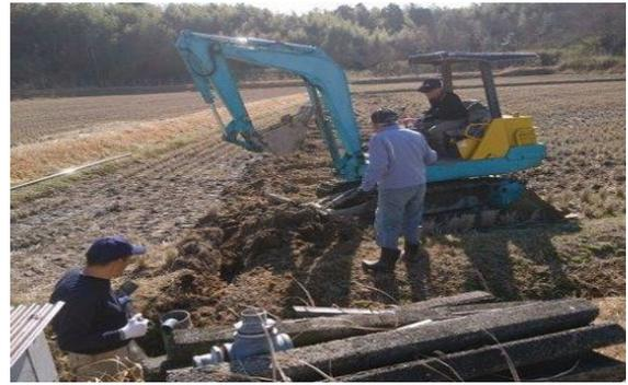
写真5 暗渠排水の整備補修
