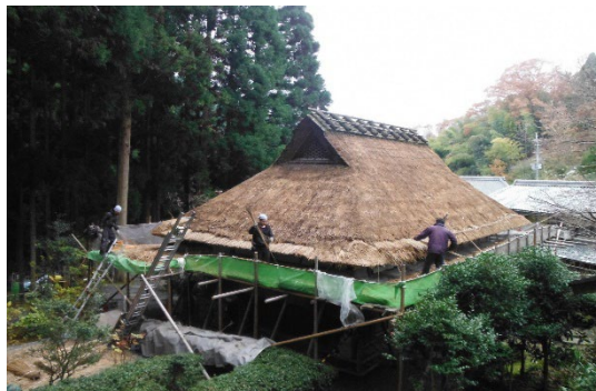
写真 1 永谷宗円生家 改修の様子
