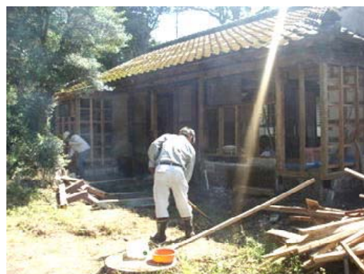
写真3 住民による空き家改修
