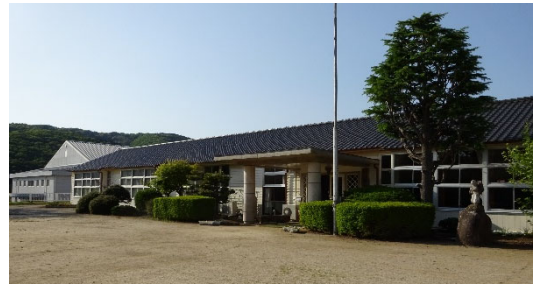
写真 1 朝日里山学校外観
