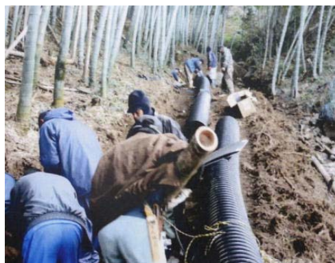
写真1 コルゲート管の埋設
