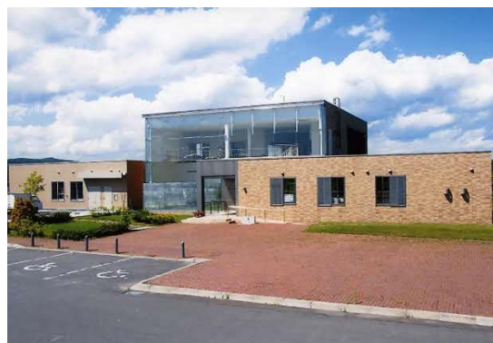
写真1 鶴居村農畜産物加工施設 「酪楽館」
