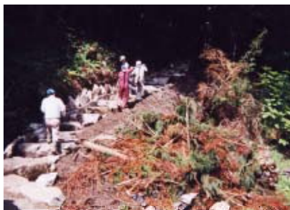
遊歩道の手作り整備
