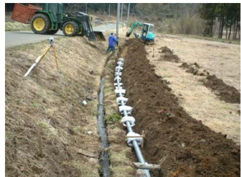
写真4 下水道工事の様子
