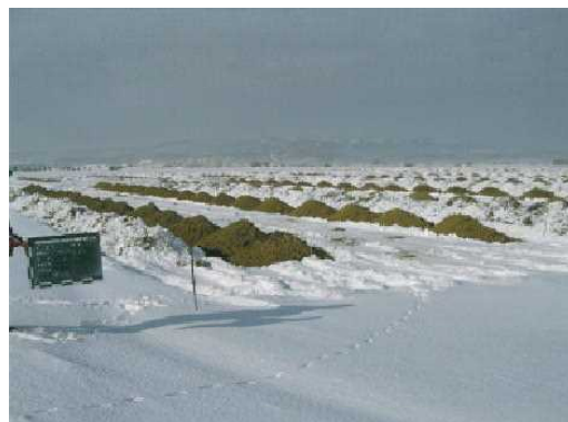
事業実施中（冬客土） （平成20年1月）
