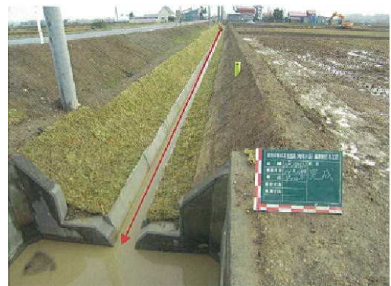
事業実施後（排水路） （平成20年11月撮影）
