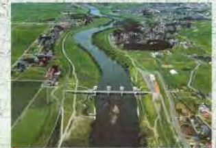
鳴瀬川下流頭首工
