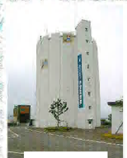
佐賀揚水機場
