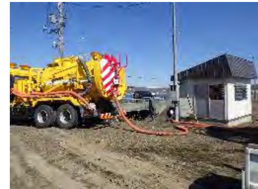
揚水機場の土砂上げ
