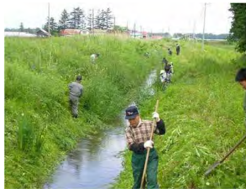
排水路の草刈り
