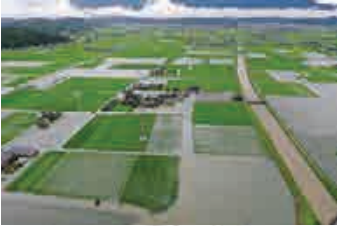
用排水路整備前
