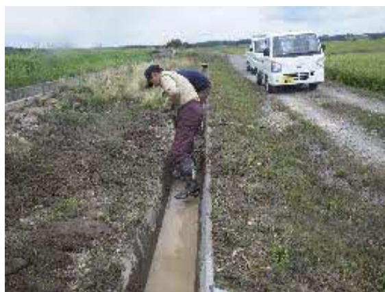
排水路の土砂上げ
