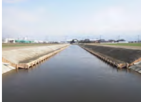
用水路整備後
