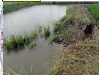
排水路整備前
