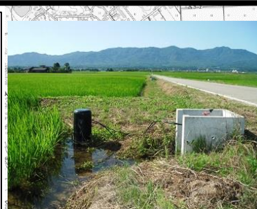
水路のパイプライン化
