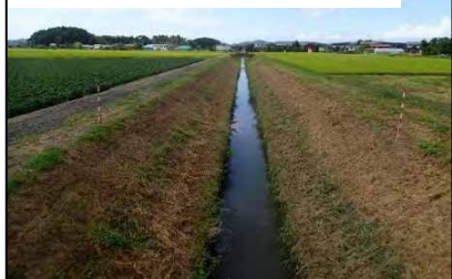
五千石川排水路(整備前)
