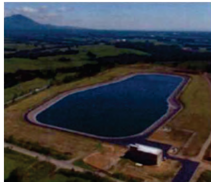
美蔓貯水池(新設)
