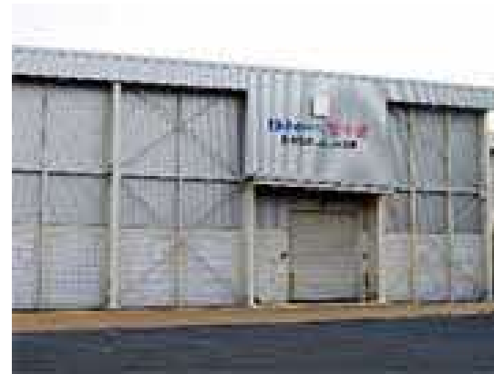
もち米貯蔵施設「ゆきわらべ雪中蔵」 （JA道北なよろが運営）
