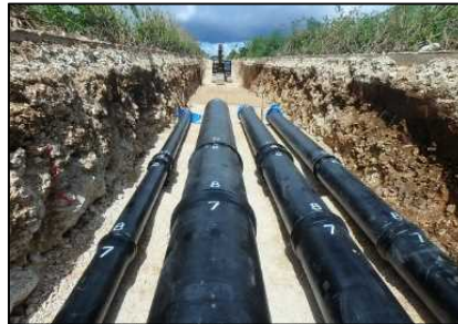
牧山幹線水路等工事
