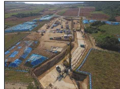
仲原地下ダム工事
