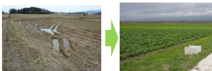
暗渠排水の整備
