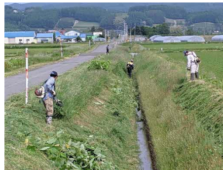
排水路周辺の草刈り
