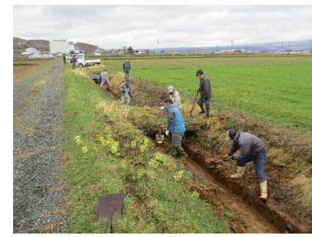
排水路の土砂上げ
