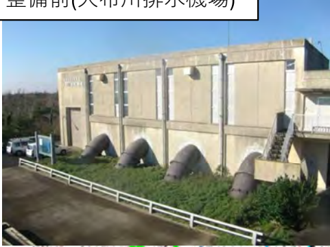
整備前(大布川排水機場)
