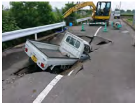
道路陥没状況
